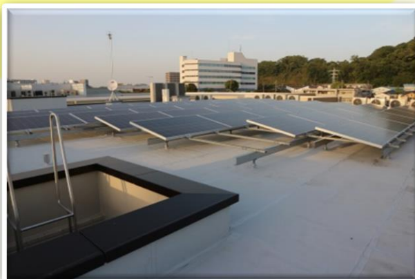
へいあん片瀬鵜沼 太陽光発電設備
